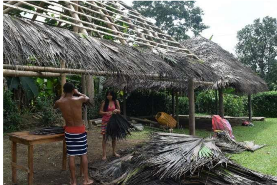
Figura 7. Estructura de la cubierta de la vivienda indígena Tsáchila, Santo Domingo, Ecuador.
