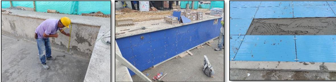
Además, se verifica minuciosamente la adherencia de las cerámicas, asegurándose de que estén firmemente colocadas. Para este propósito, se utiliza un elemento de madera que se coloca en contacto con la cerámica con el fin de que con la ayuda del sonido que se produce se verifique el estado adherencia de cada cerámica, ya un resultado satisfactorio se traduce en que no se perciba un sonido hueco al golpear suavemente la superficie. (Figura 74).
