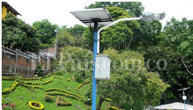
Imagen 16. Instalación de paneles solares para servicios públicos
