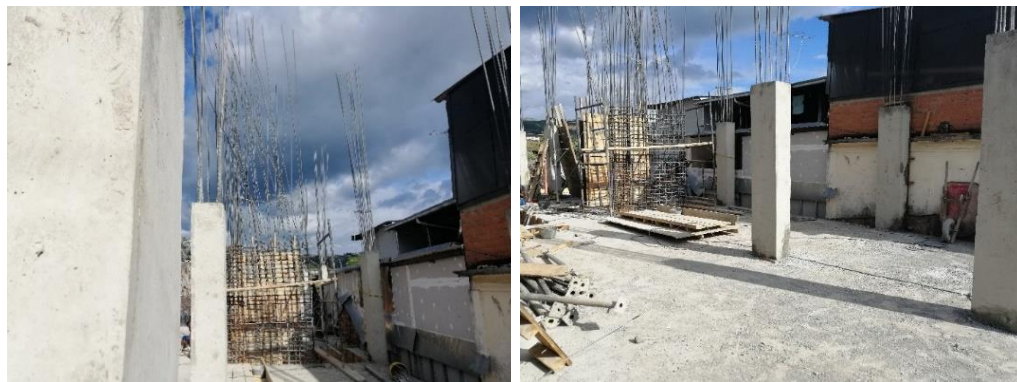
Foto 17. Fundición de columnas segundo piso (19/07/19)
