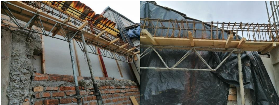
Foto 7. Ejecución de formaletas de viga primer piso (19/06/19)
