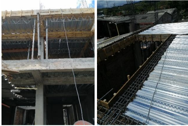
Foto 22. Instalación de lámina Deck Steel segundo piso (12/08/19)
