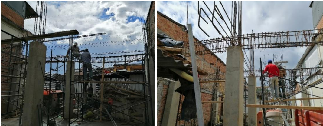
Foto 3. Ejecución de acero vigas primer piso (11/06/19)
