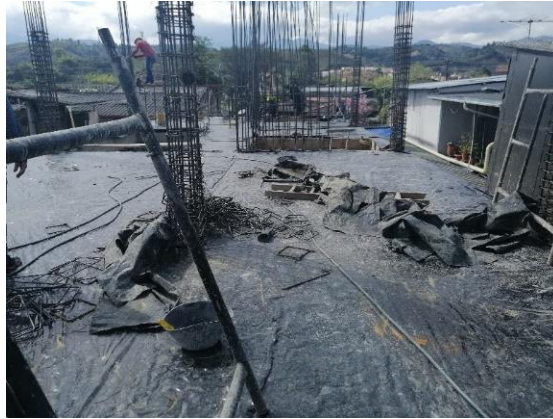
Foto 26. Adelanto de columnas del segundo piso (12/08/19)
