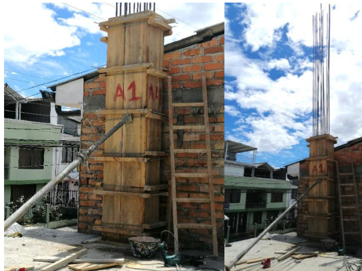
Foto 15. Formaleta columnas segundo piso (15/07/19)
