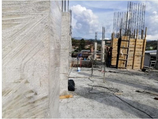
Foto 35. Formaletas de pantalla del tercer piso (28/09/19)
