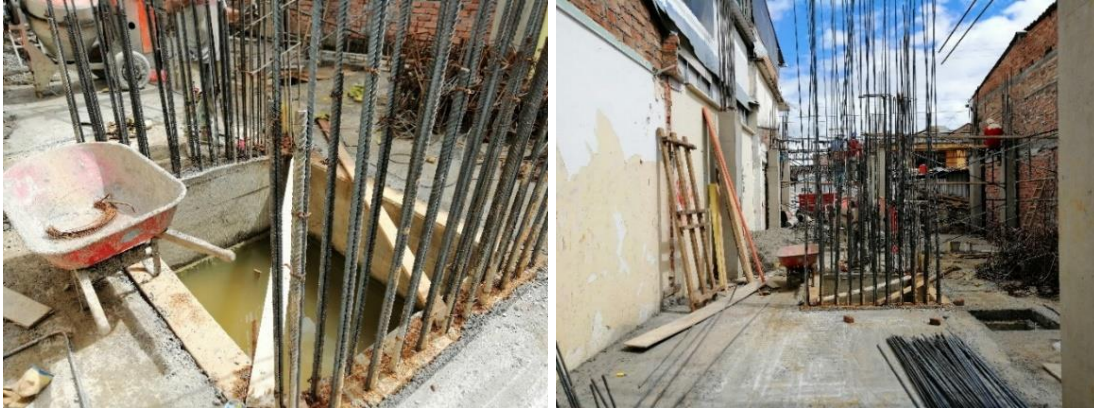
Foto 4. Estructura pantalla primer piso (13/06/19)
