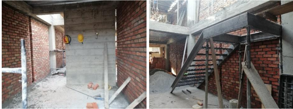
Foto 30. Cerramiento de muro de primer piso (31/08/19)
