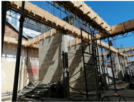
Foto 8. Vigas primer piso (25/06/19)
