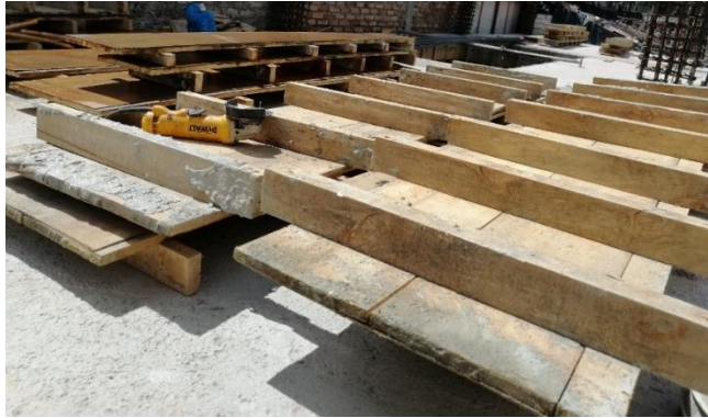
Foto 18. Preparación de formaletas de pantalla segundo piso (22/07/19)
