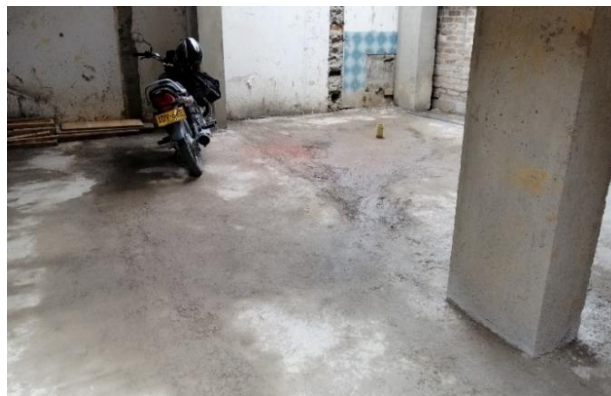
Foto 28. Limpieza del primer piso (24/08/19)
