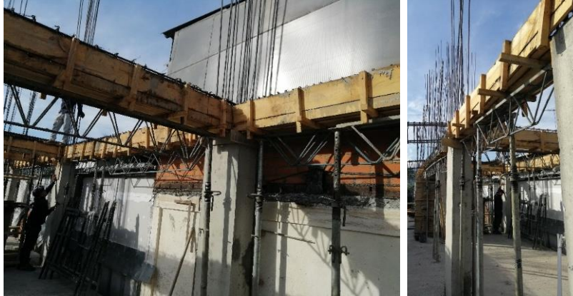
Foto 21. Preparación vigas segundo piso (08/08/19)
