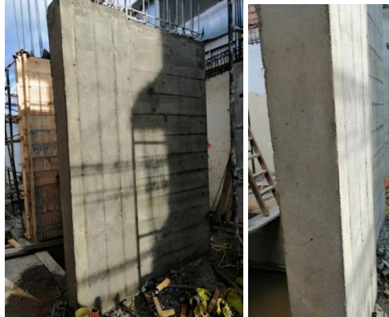
Foto 6. Resultado de la fundición de formaletas primer piso (18/06/19)
