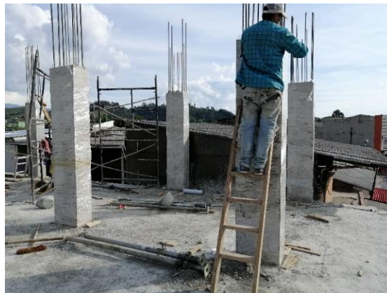
Foto 36. Fundición columnas del tercer piso (01/10/19)
