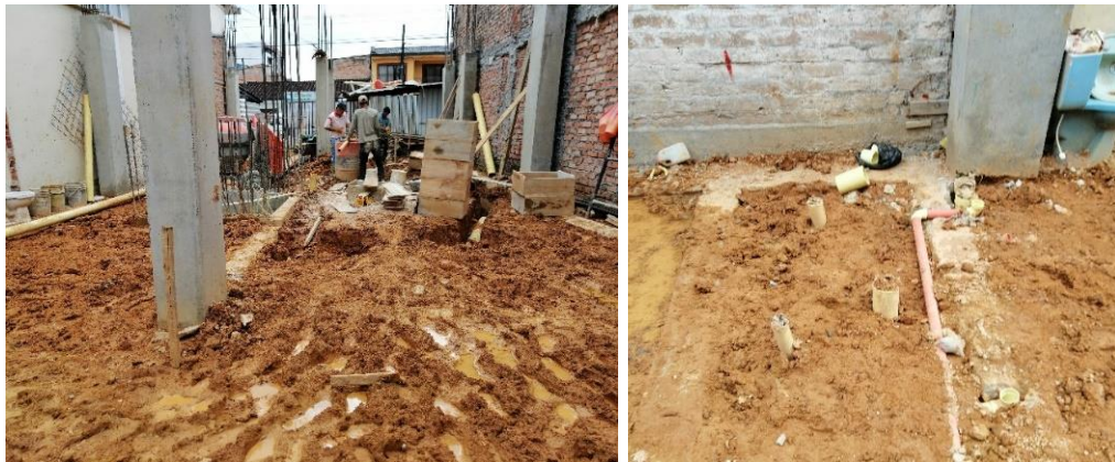
Foto 1. Entrega de obra (04/06/19)
