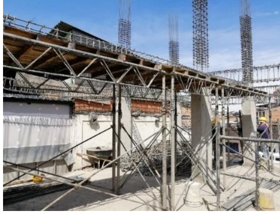
Foto 33. Instalación tableros de vigas del tercer piso (09/09/19)
