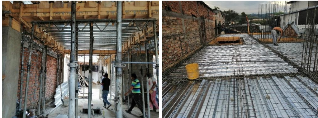
Foto 11. Instalación de lámina Deck Steel segundo piso (03/07/19)
