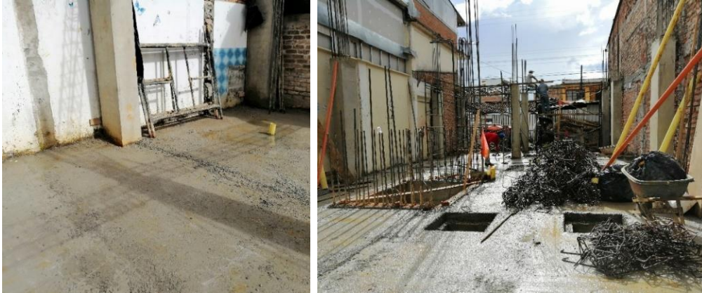
Foto 2. Fundición de losa de primer piso (10/06/19)
