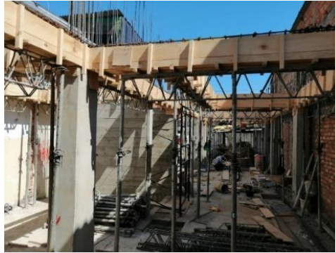
Foto 10. Fundición vigas primer piso (01/07/19)
