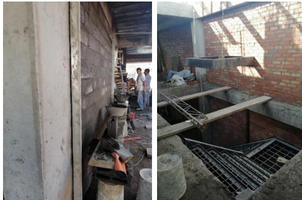
Foto 37. Cerramiento muros del segundo piso (02/10/19)
