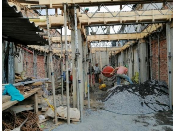
Foto 9. Preparación vigas primer piso (26/06/19)
