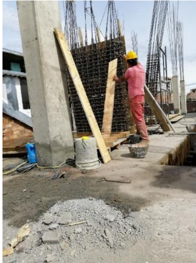
Foto 19. Fundición de formaleta segundo piso (24/07/19)
