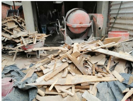
Foto 32. Limpieza del primer piso (05/09/19)
