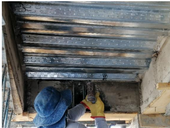
Foto 25. Soplete para la losa del segundo piso (18/08/19)
