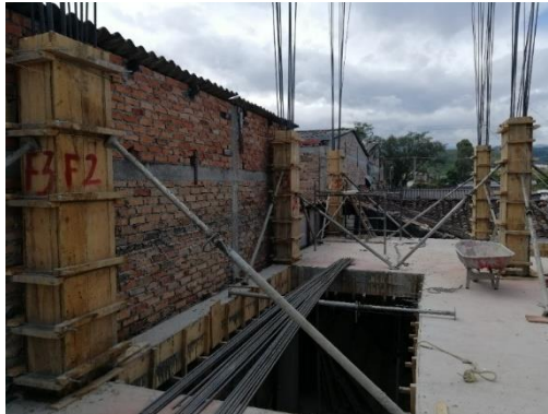
Foto 16. Terminación de formaletas de columnas segundo piso (18/07/19)
