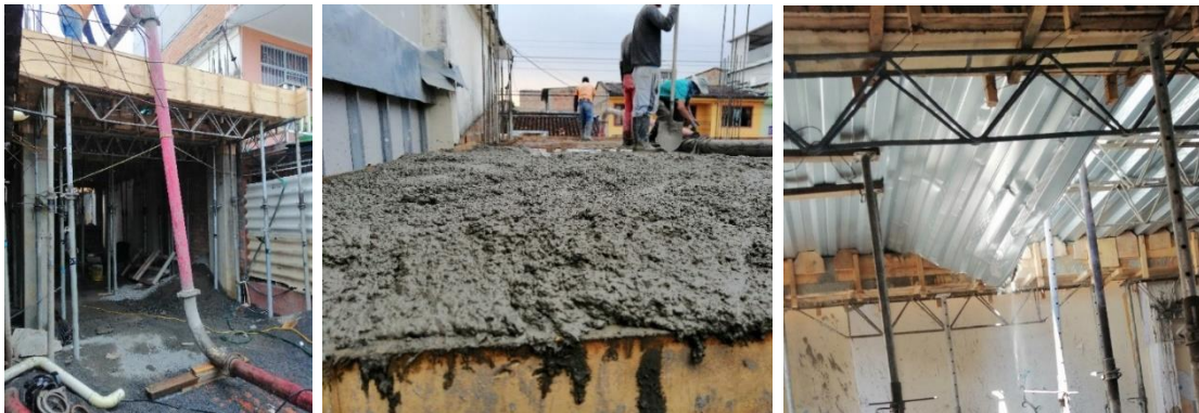
Foto 12. Fundición losa segundo piso (04/07/19)
