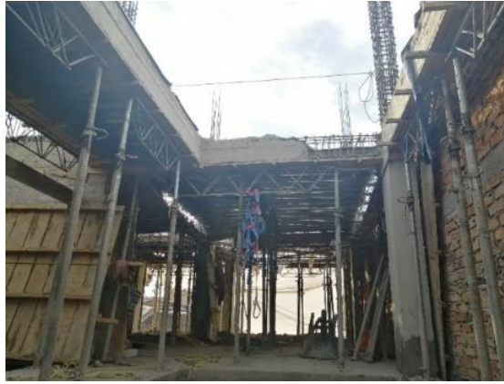
Foto 31. Avance de demolición de losa del tercer piso (05/09/19)
