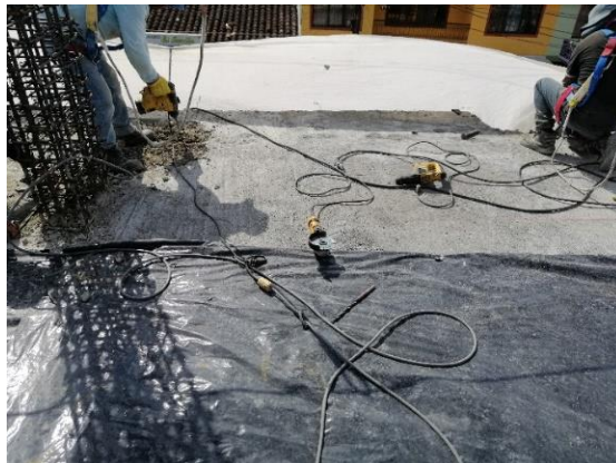
Foto 24. Losa forrada en plástico de segundo piso (17/08/19)
