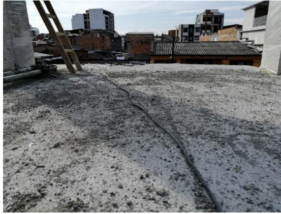
Foto 34. Fundición de losa del tercer piso (16/09/19)
