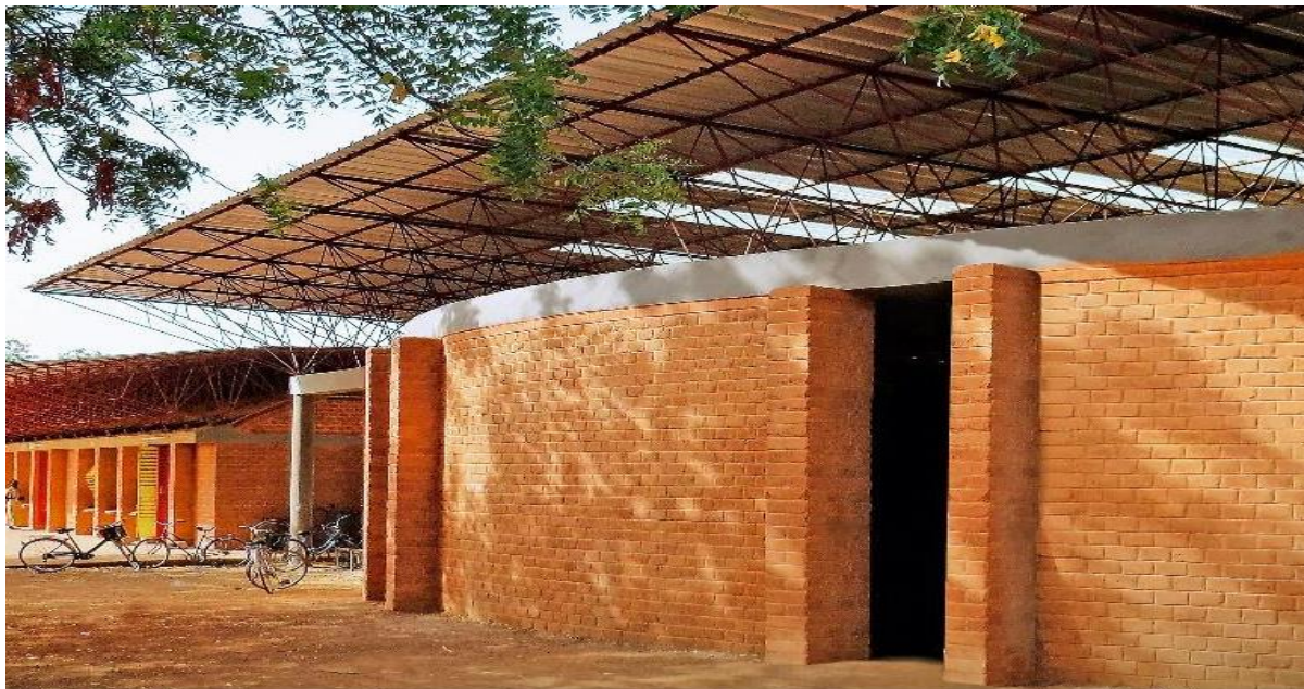
Ilustración 9. Tipo de pega que utilizaron para construir la biblioteca
