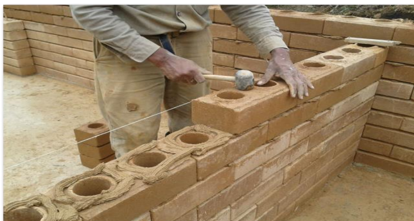
Ilustración 10. Detalle constructivo de la pega en soga.
