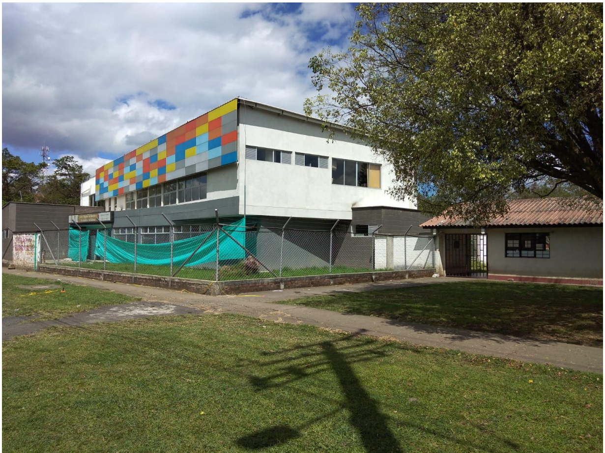
Ilustración 6. Acceso principal actual
