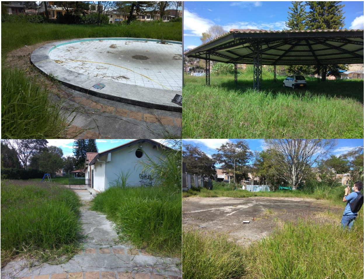
Ilustración 9. Zonas comunes - estado actual
