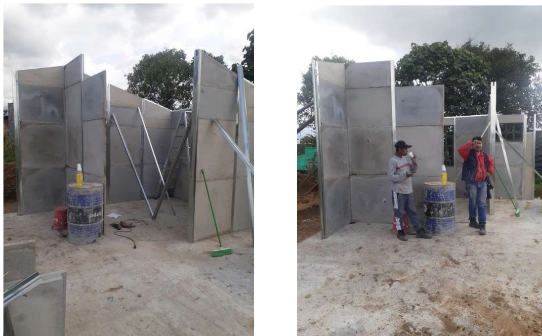
Fuente 37. Suministrada por la empresa Integral Construcciones S.A.S.
