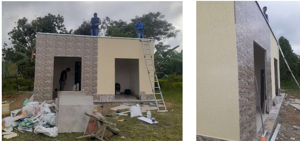
Fuente 36. Suministrada por la empresa Integral Construcciones S.A.S.
