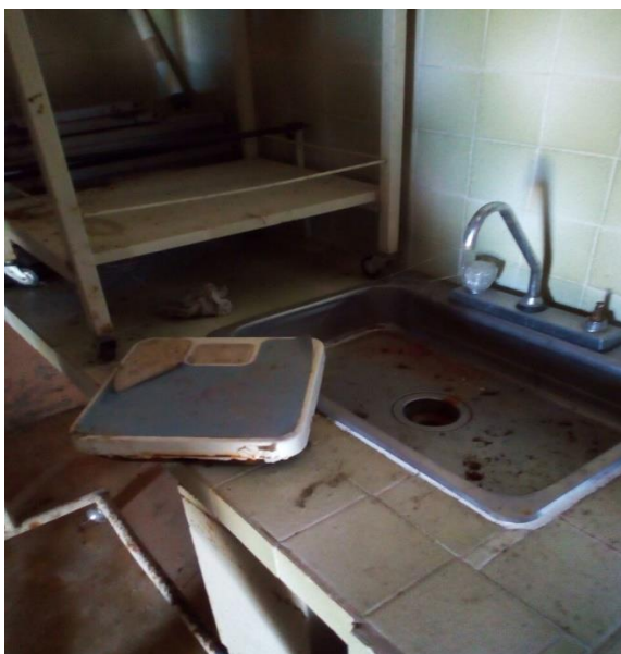
Ilustración 16. Equipos Puesto de Salud La Primavera Fuente: Elaboración Propia.
