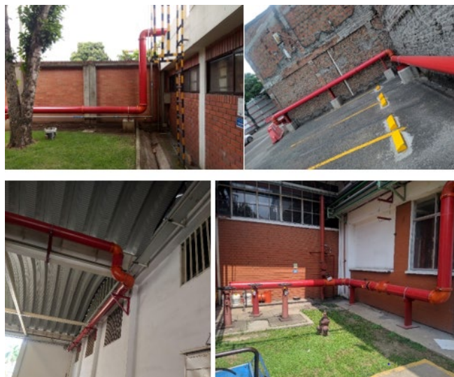
Figura 25. Nueva red de distribución principal en 10"
