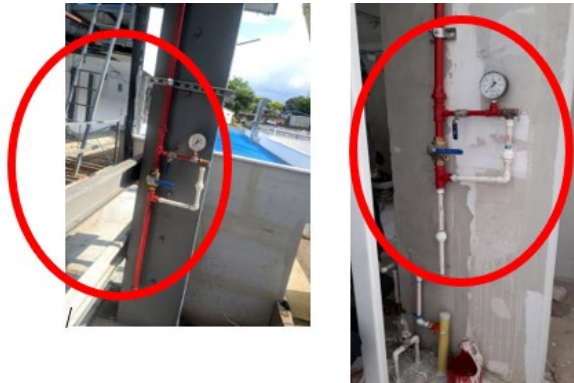
Figura 14. Válvula de prueba y drenaje ITC
