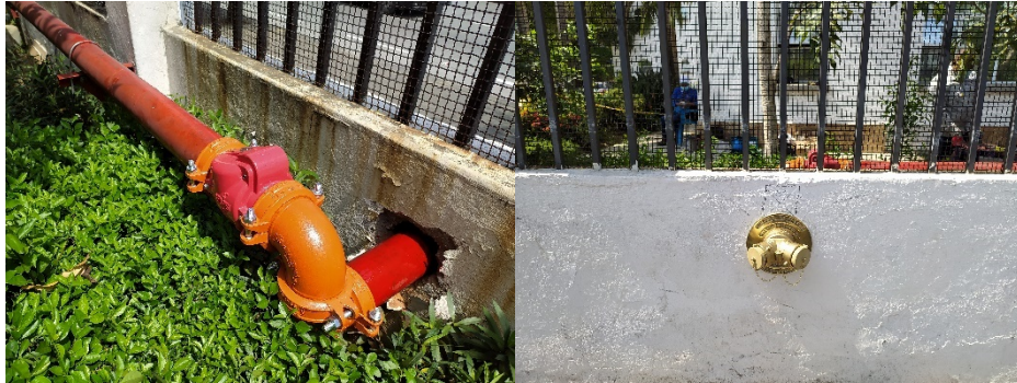
Figura 18. Siamesas inyección columna.2
