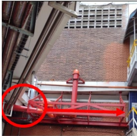
Figura 26. Escuadra de giro sismorresistente 10”
