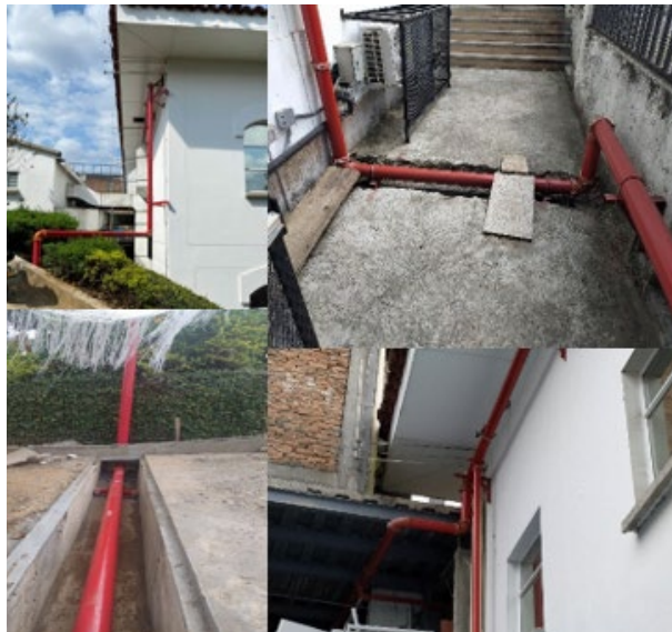
Figura 15. Tubería principal 4"
