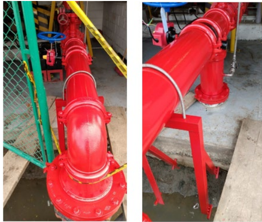
Figura 28. Instalación de tuberías papeles nacionales.
