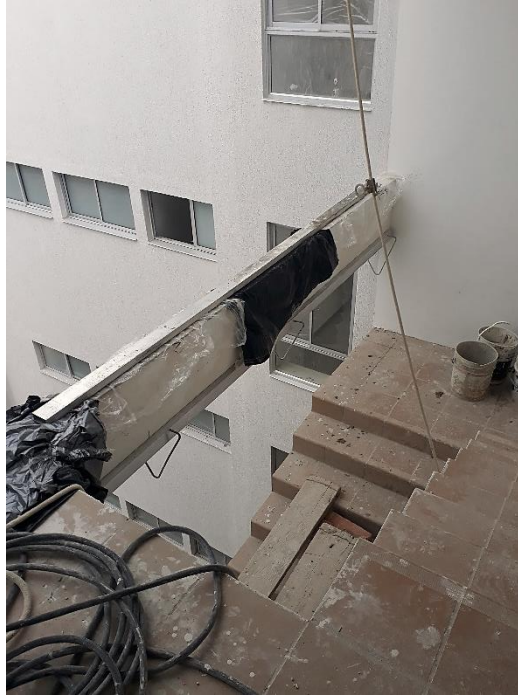
Foto 27. Aplome y medida de vigas
