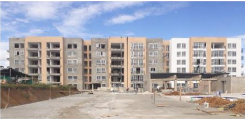
Fotografía: Estado de torres A y B (23/05/19)
