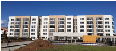
Fotografía: Estado de torres A y B (06/07/19)
