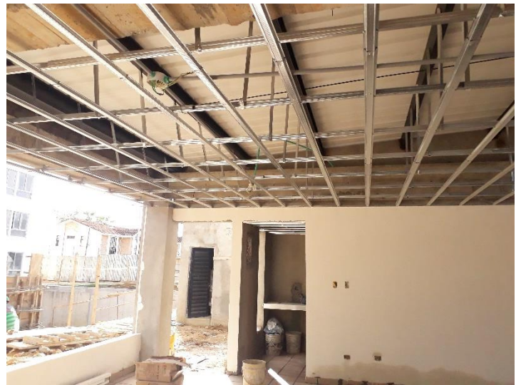
Foto 23. Instalación estructura cielo en salón social
