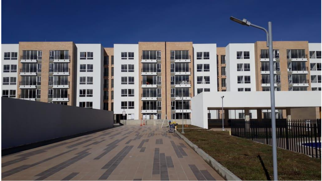
Foto 34. Fachada interior edificios (02/08/19)
