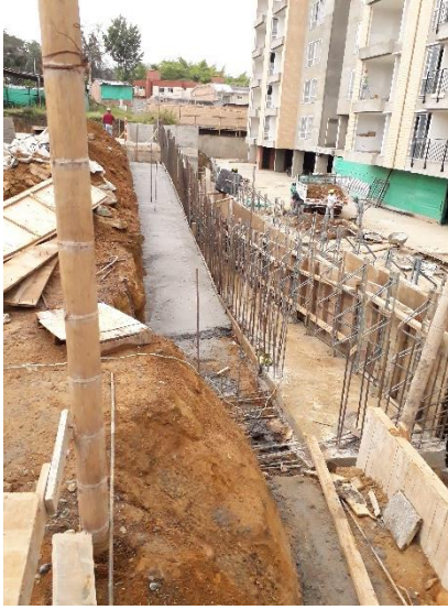
Foto 15. Avance fundición rampa
