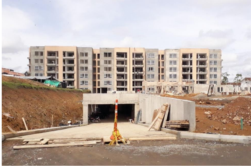
Foto 6. Fachada interior edificios (02/04/19)
