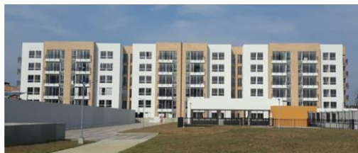
Fotografía: Estado de torres A y B (02/08/19)
