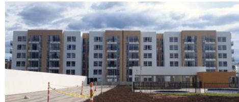
Fotografía: Estado de torres A y B (26/07/19)
