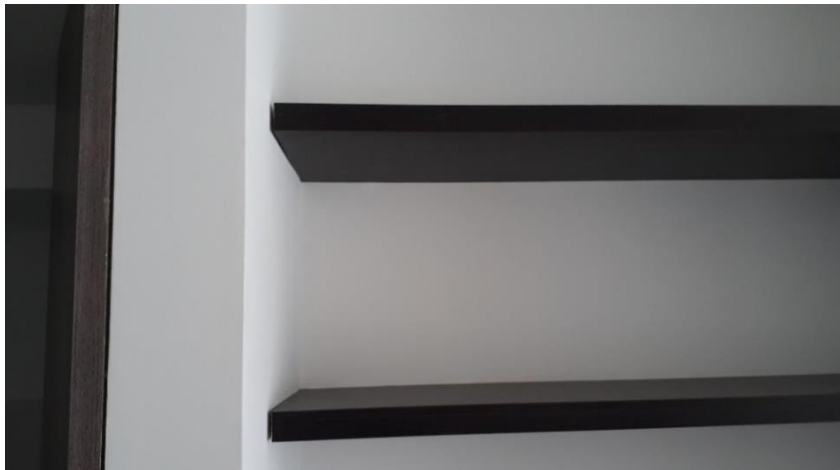
Foto 11. Nicho comedor con luz debido a falta de escuadra en muros
