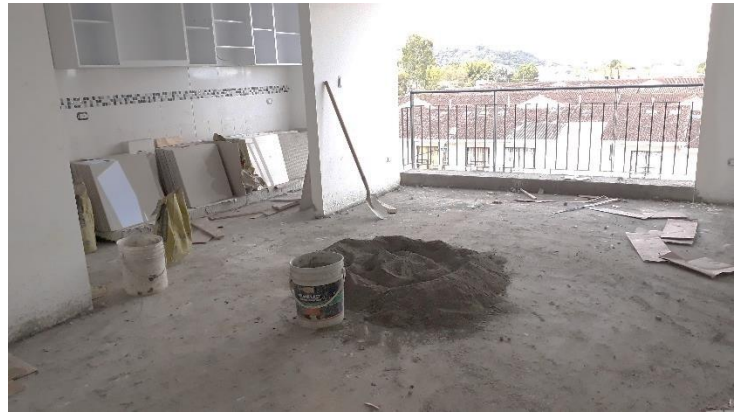
Foto 4. Desmonte de enchape de piso
