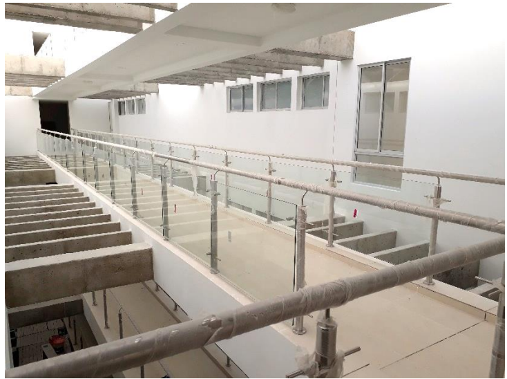
Foto 28. Avance en instalación de vidrio templado
