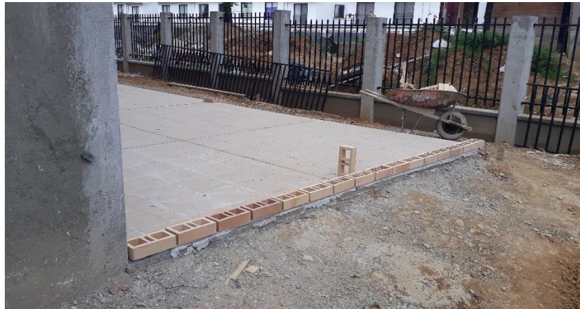
Foto 26. Planteo de hilada para muro de cerramiento patios
