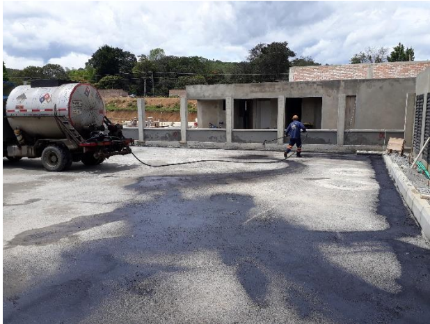
Foto 12. Imprimación de zona parqueaderos visitantes Compactador vibratorio
