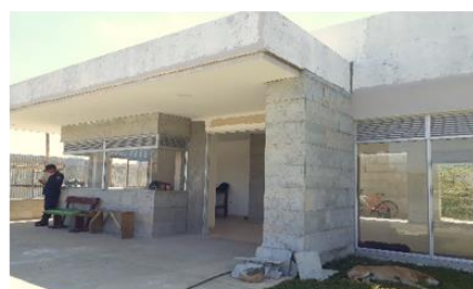
Fotografía: Estado portería (04/07/19)
