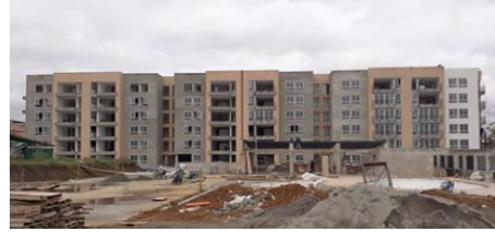
Fotografía: Estado de torres A y B (13/05/19)
