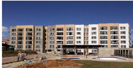
Fotografía: Estado de torres A y B (03/06/19)
