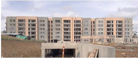
Fotografía: Estado de torres A y B (17/04/19)
