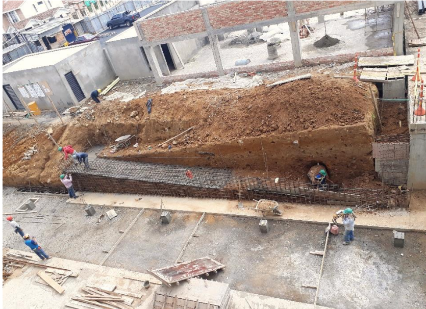
Foto 14. Inicio instalación formaleta rampa
