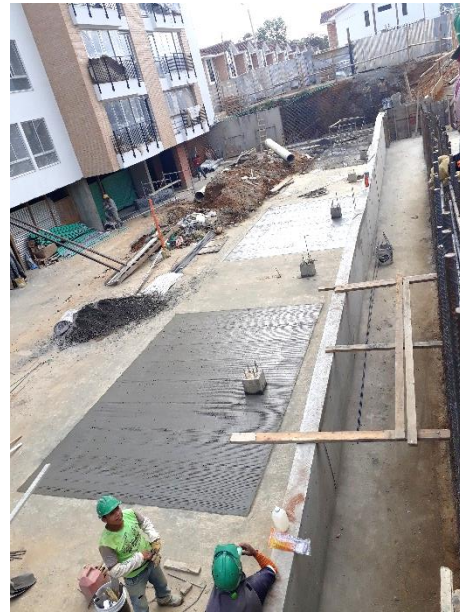
Foto 18. Culminación fundición losa
