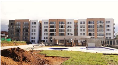
Fotografía: Estado de torres A y B (12/06/19)
