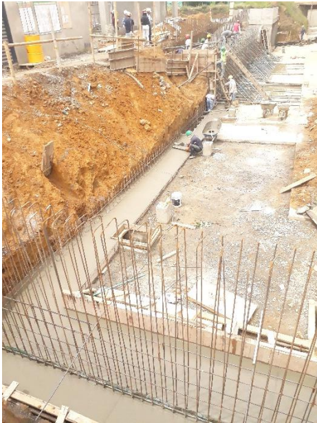
Foto 17. Inicio fundición losa parqueaderos
