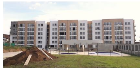
Fotografía: Estado de torres A y B (20/06/19)
