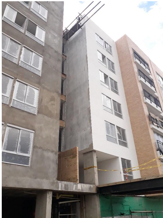
Foto 21. Avance en fachada torre B
