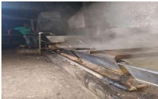
Fotografía 3. Proceso de rellenado de tanques
