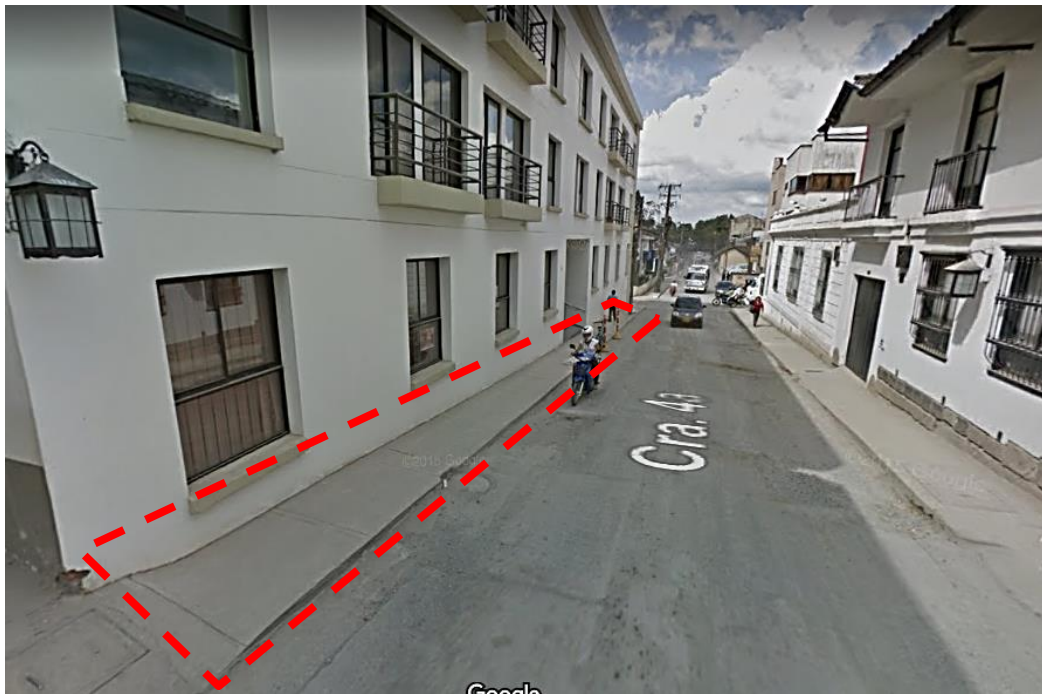
Figura 67. Espacio público del edificio del tribunal administrativo de Popayán (Fuente: elaboración propia, 2017)
