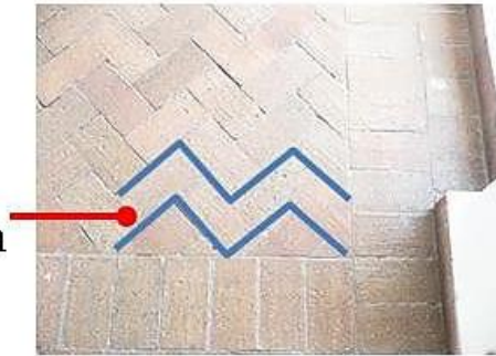
Figura 97. Foto del tipo de piso adecuado en edificio #1 (Fuente: elaboración propia, 2018)
