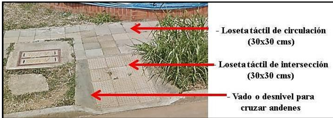
Figura 39. Fotografía de disposición de vados y losa táctil (Fuente: elaboración propia, 2018)
