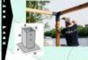
En este paso empezamos a colocar las uniones metálicas con los bastidores de madera para luego ser atornillados; al igual que anclando el módulo al suelo con el medio metálico.
