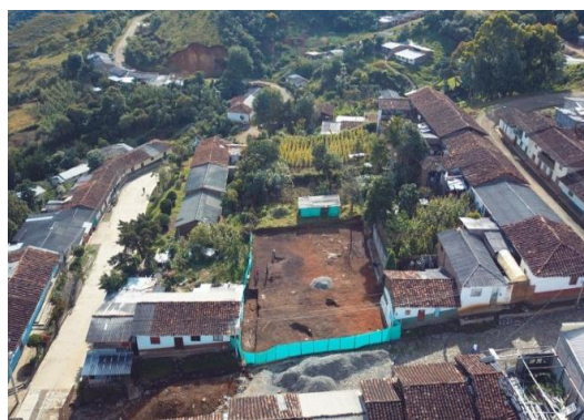
Imagen 12 imagen aérea del terreno de obra
