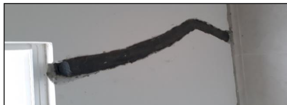
Ilustración # 87. Mortero y SIKA JOINT
