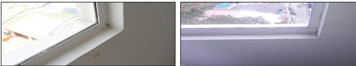
Ilustración # 84, 85. Filtración en cartera
