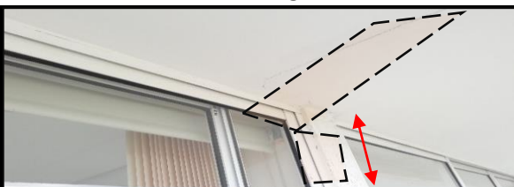
Ilustración #145. Fisura longitudinal
