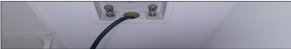
Ilustración # 89. Lavado con sonda plástica
