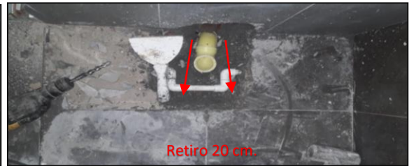
Ilustración #124. Instalación sifón
