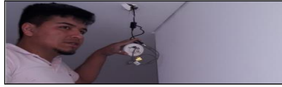
Ilustración #128. Filtración cámara de seguridad
