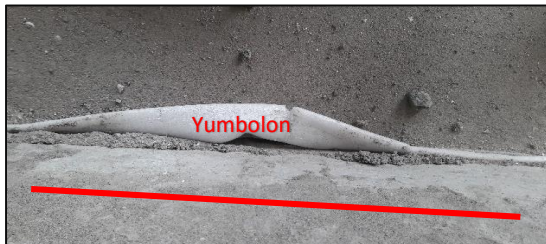
Ilustración # 33. Dilatación con Yumbolon
