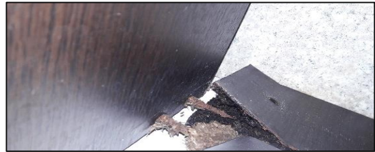
Ilustración # 38. Aglomerado descompuesto
