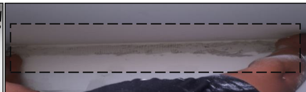
Ilustración #138. Aplicación de cinta maya
