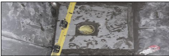
Ilustración #125. Instalación de fichas
