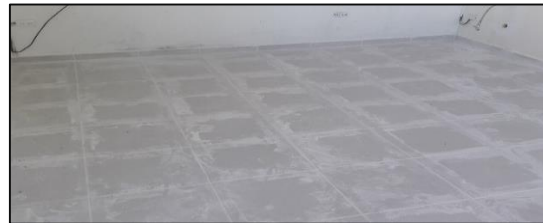
Ilustración # 48. Fragua por decoloración
