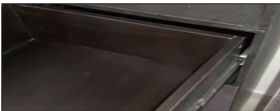
Ilustración # 117. Cajón con dificultad al abrir
