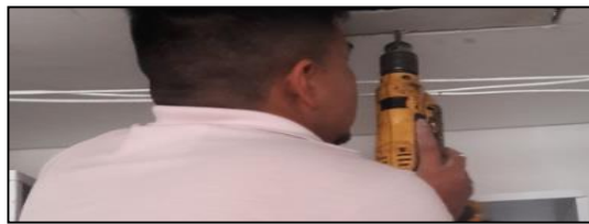
Ilustración #130. Instalación de lámina
