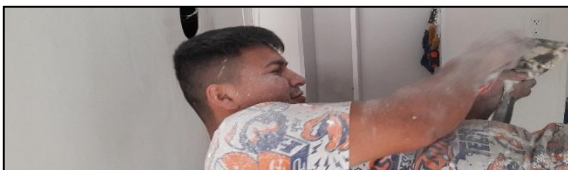
Ilustración #158. Arreglo del cielo raso
