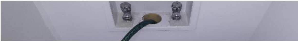
Ilustración #155. Lavado con sonda plástica
