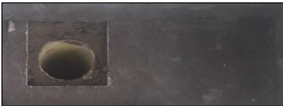
Ilustración # 115. Fragua en el sifón del 902
