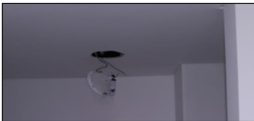
Ilustración # 67. Bala led descolgada
