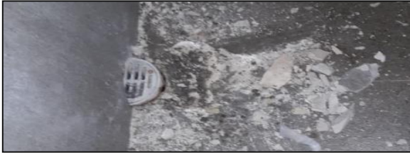
Ilustración #121. Media rejilla instalada
