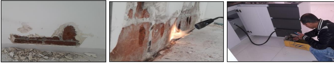
Ilustración # 96. Pared encintada, Ilustración # 97. Ladrillo al calor, Ilustración # 98. P. presión
