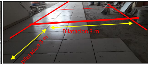
Ilustración # 34. Dilatación cada 3 M2
