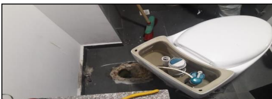
Ilustración # 91. Retiro del inodoro
