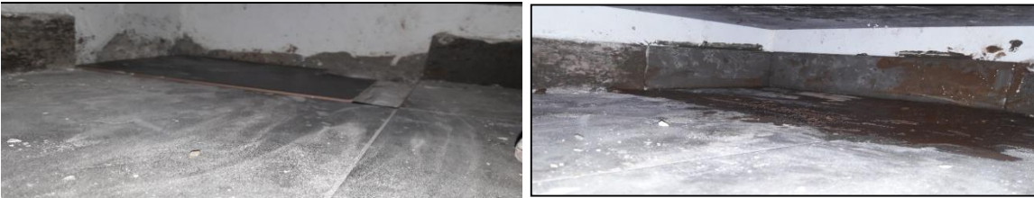
Ilustración # 110. Corte de ficha y guarda escoba Ilustración #111. Aplicación de fragua
