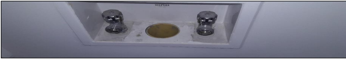
Ilustración # 88. Sifón con mal olor
