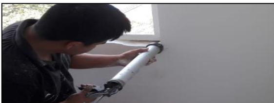
Ilustración # 86. Aplicación de SIKA FLEX
