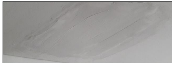
Ilustración #116. Aplicación de estuco
