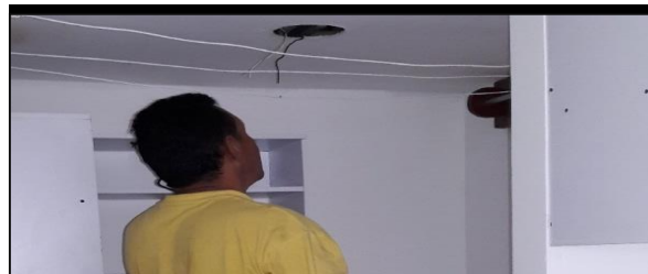
Ilustración # 68. Intervención del eléctrico
