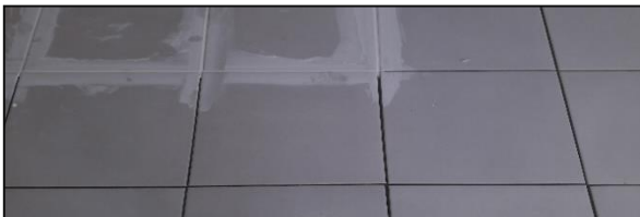
Ilustración # 59. Aplicación de fragua
