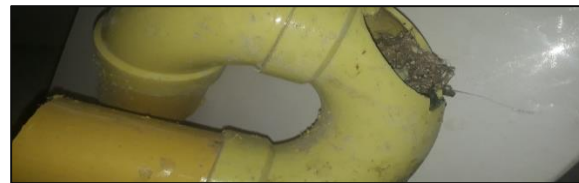
Ilustración #157. Desinstalación de tubería
