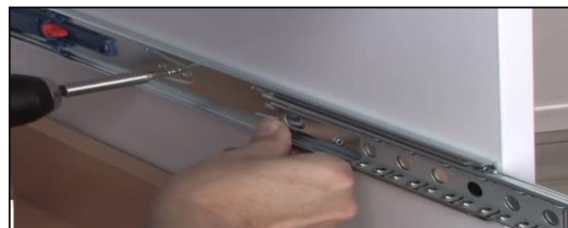
Ilustración #120. Instalación corredera
