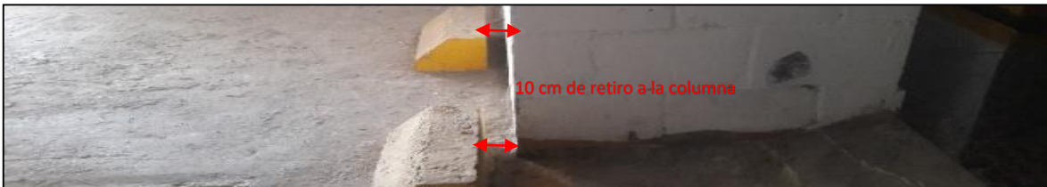
Ilustración # 99. Tope llanta
