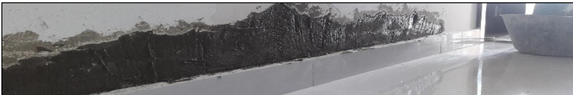
Ilustración # 94. Aplicación de mortero
