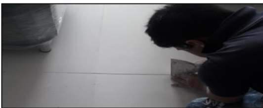
Ilustración # 47. Fragua levantada
