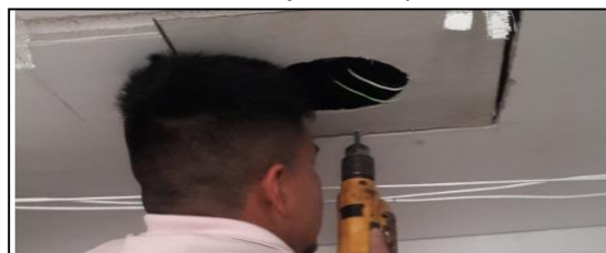
Ilustración # 70. Sujeción al perfil metálico
