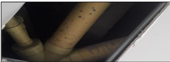
Ilustración #129. Perforación de lámina
