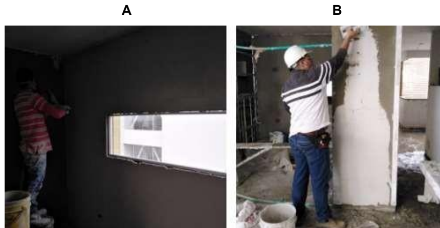
Imagen 22. 22A. Relleno de Muros, 22B. Relleno + Estuco.
