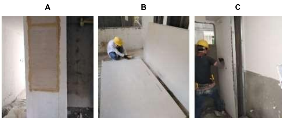
Imagen 41. 41A. Tratamiento de Juntas., 41B. Corte Lámina Board, 41C. Armado Baños.
