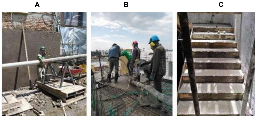
Imagen 26. 26A. Repello Acceso, 26B. Fundición Losa, 26C. Fundición Grada.
