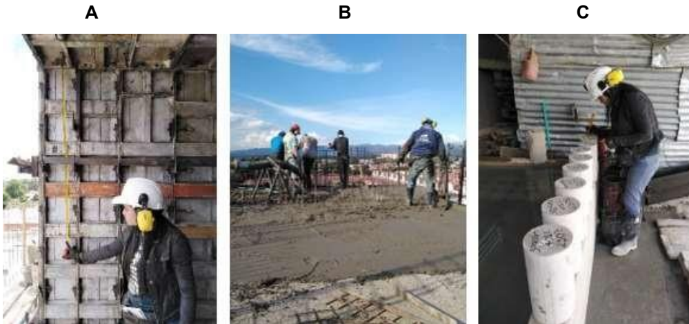
Imagen 25. 25A. Nivelación Formaleta, 25B. Fundición Torre E, 25C. Cilindros de Prueba.
