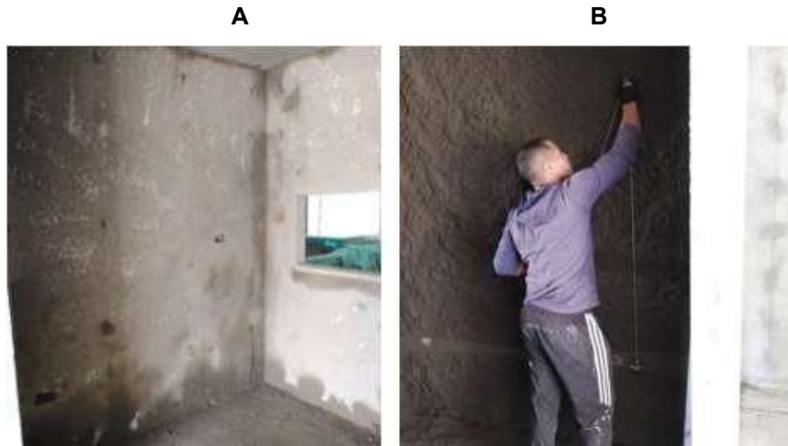
Imagen 19. 19A. Repello de Muros, 19B. Champeo de Muros.
