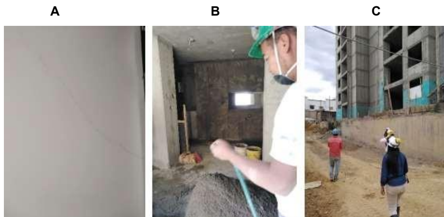
Imagen 29. 29A. Chequeo Dilataciones, 29B. Repello Torre E, 29C. Vía Posterior.
