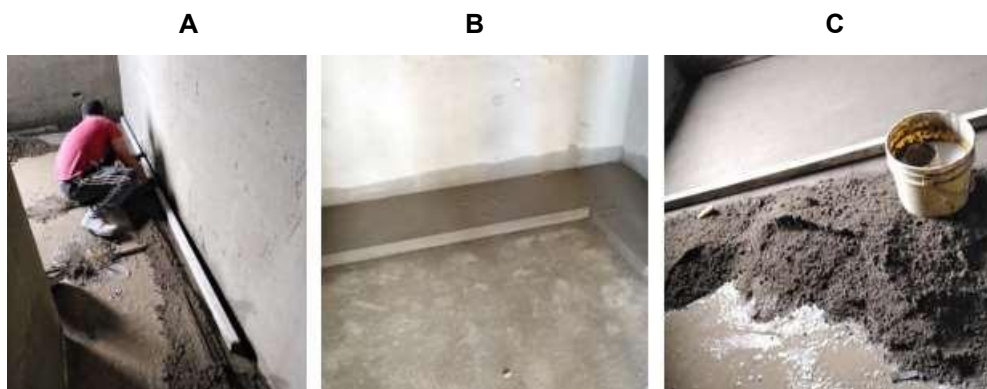
Imagen 33. 33A. Repello de Pisos., 33B. Pollo Cocina, 33C. Chequeo Niveles.
