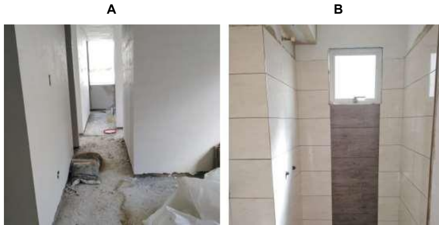
Imagen 23. 23A. Enchape Baños, 23B. Estuco en Apartamentos.
