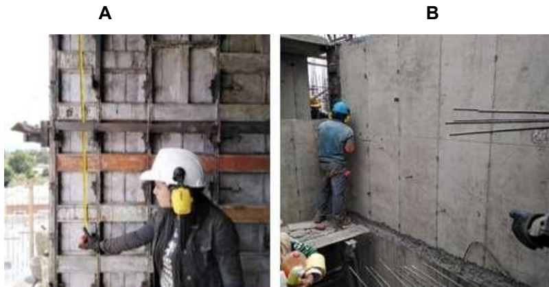
Imagen 16. 16A.Chequeo de Plomos, 16B. Chequeo de Niveles.
