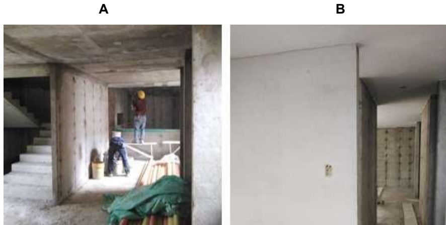
Imagen 20. 20A. Relleno de Cielos, 20B. Relleno de Muros.
