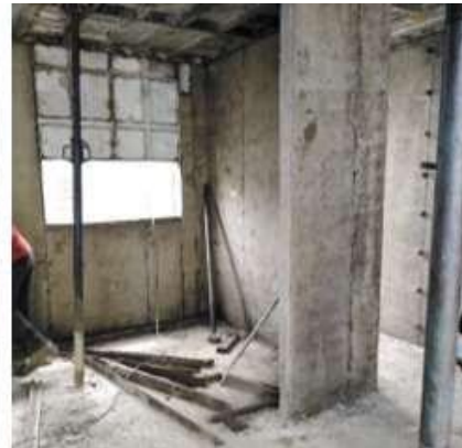
Imagen 15. 15A. Cimbra de gradas ppal, 15B. Desencofrado Muros.
