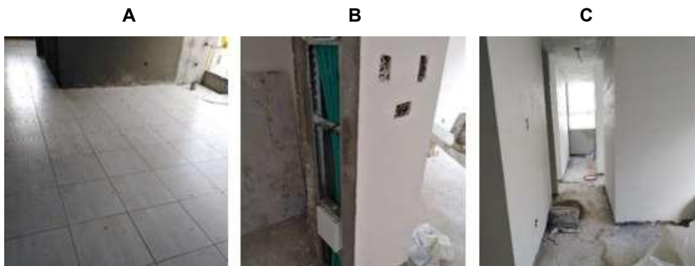
Imagen 37. 37A. Enchape., 37B. Cajas Eléctricas, 37C. Estuco en Cielos.
