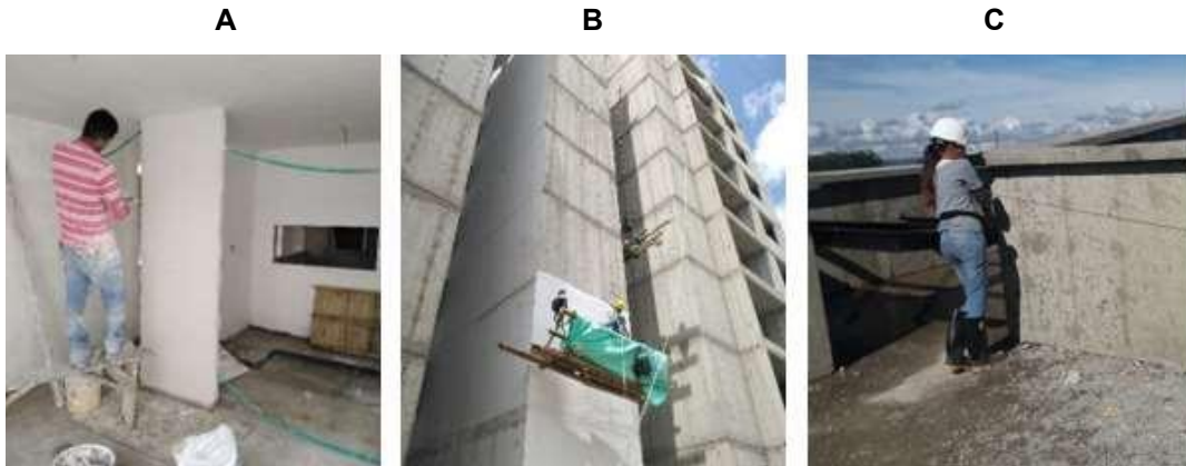
Imagen 34. 34A. Detallado Estuco., 34B. Trabajo en Altura, 34C. Cubierta.
