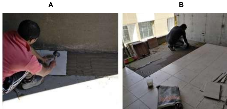
Imagen 21. 21A. Enchape Piso Habitación Principal, 21B. Enchape Piso Sala.
